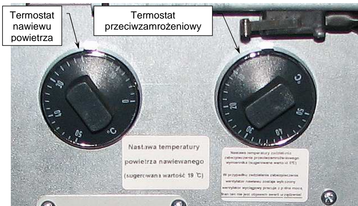
Rys. 14. Nastawniki termostatów centrali wentylacyjnej Economic 300 II (UWAGA: w wersji WATER na płycie nie jest montowany nastawnik termostatu temperatury nawiewu, regulacja ta jest przeprowadzana za pomocą zaworu termostatycznego umieszczonego przy nagrzewnicy)
